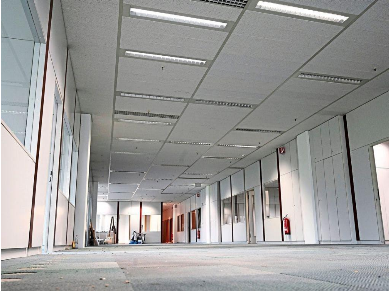
Das ehemalige Großraumbüro bietet Platz für Gruppenräume, einen Kreativraum, für die Büros der Verwaltung und für ein Café. Foto: Oliver Schwabe
